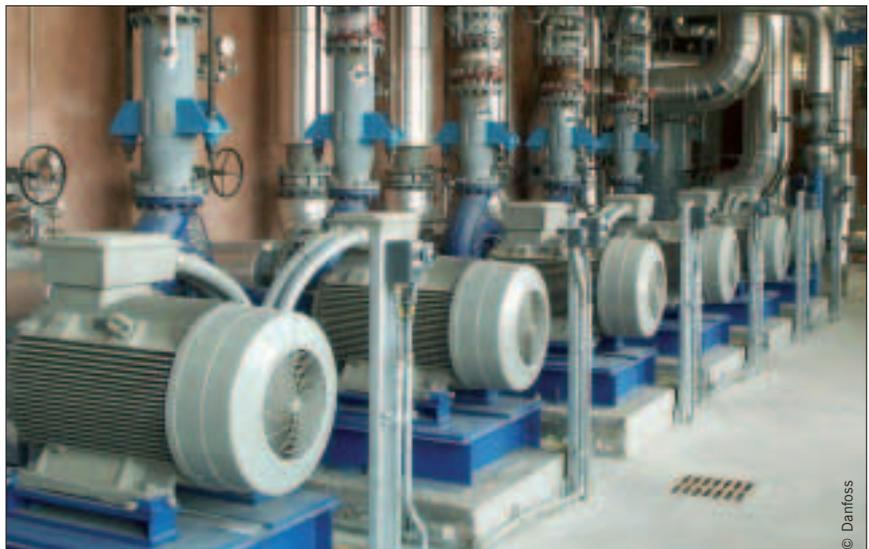
Ein Frequenzumrichter kann bei einer 30-kW-Pumpe mit Drosselklappe, die 3.000 h/Jahr im Einsatz ist, rund 3.000 Euro an Energiekosten einsparen.
