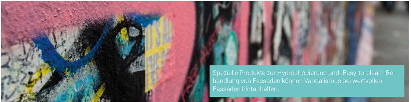
Spezielle Produkte zur Hydrophobierung und „Easy-to-clean“-Behandlung von Fassaden können Vandalismus bei wertvollen Fassaden hintanhalten.
