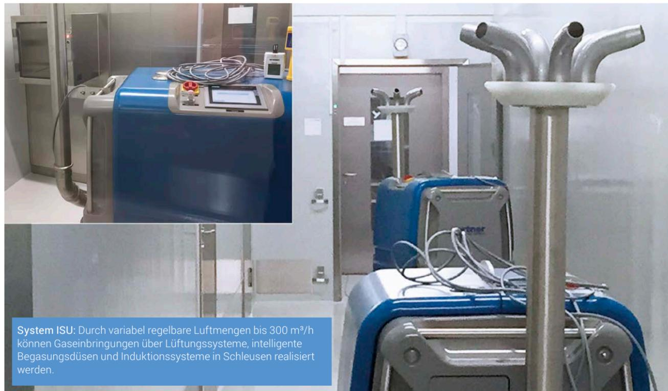
System ISU: Durch variabel regelbare Luftmengen bis 300 m³/h können Gaseinbringungen über Lüftungssysteme, intelligente Begasungsdüsen und Induktionssysteme in Schleusen realisiert werden.
