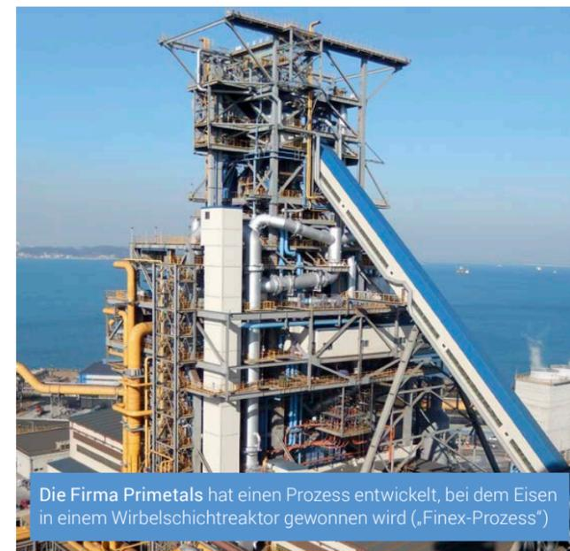
Die Firma Primetals hat einen Prozess entwickelt, bei dem Eisen in einem Wirbelschichtreaktor gewonnen wird („Finex-Prozess“)
