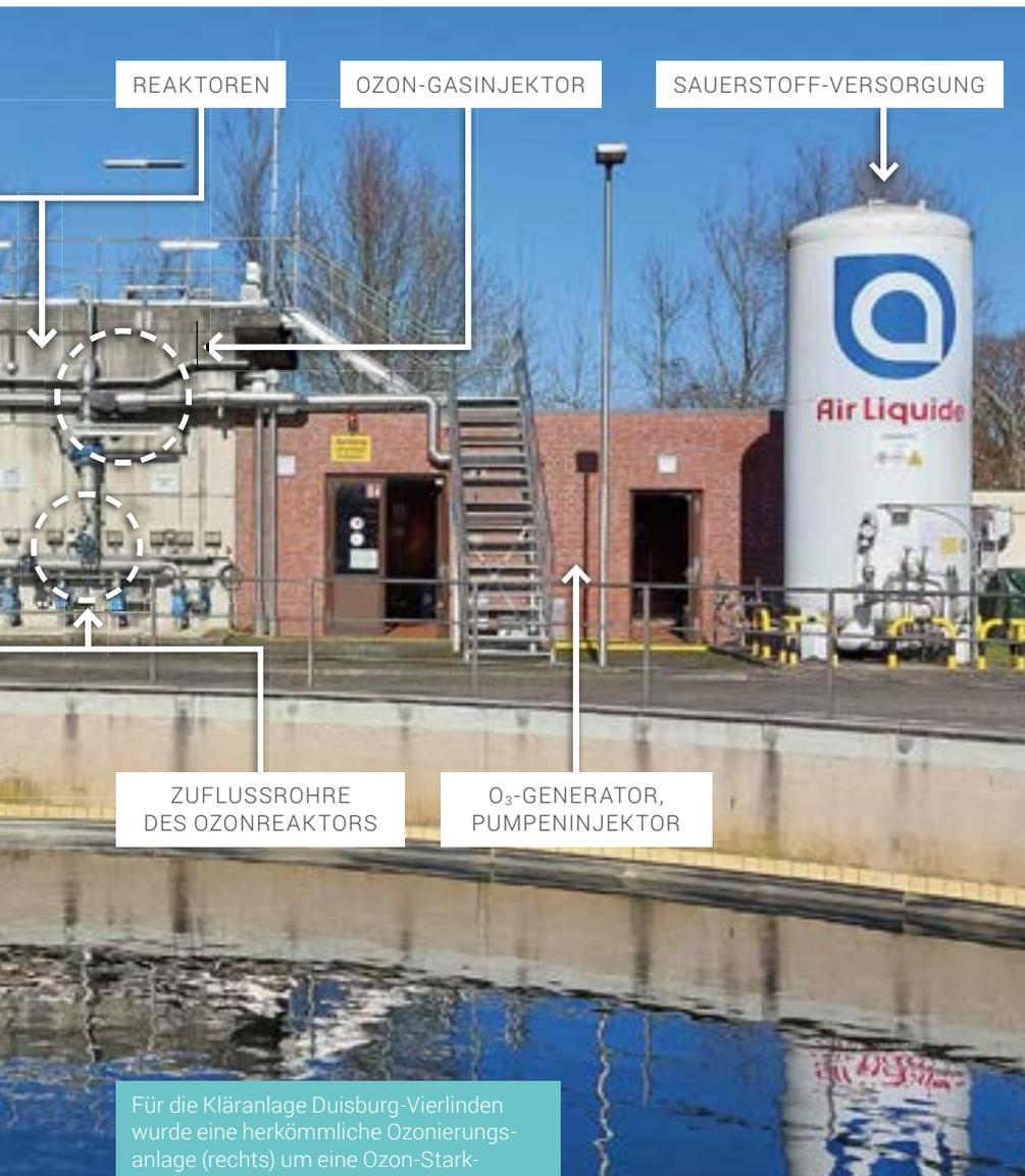
Für die Kläranlage Duisburg-Vierlinden wurde eine herkömmliche Ozonierungsanlage (rechts) um eine Ozon-Starkwasser-Anlage erweitert. Im Testbetrieb war bei gleichem Ergebnis der Ozonverbrauch des Starkwassersystems im Vergleich zum Standardverfahren um 80 Prozent geringer.
