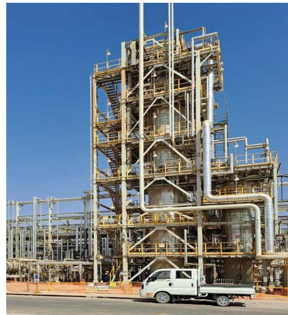
Mehr als 60 Biturox-Anlagen, in denen Erdölfractionen zu hochwertigem Bitumen verarbeitet werden, hat die Pörner-Gruppe im Laufe der Jahre realisiert.
