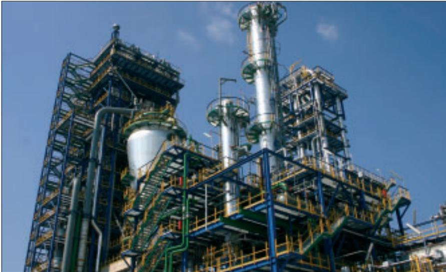
Die neue Borstar-Anlage in Wien-Schwechat. OMV-Vorstand Gerhard Roiss spricht von einem „fantastischen Prozess“: Ethylen wird während der Destillation auf 800 bis 850 ° C erhitzt und in Folge wieder auf -150 ° C abgekühlt.
