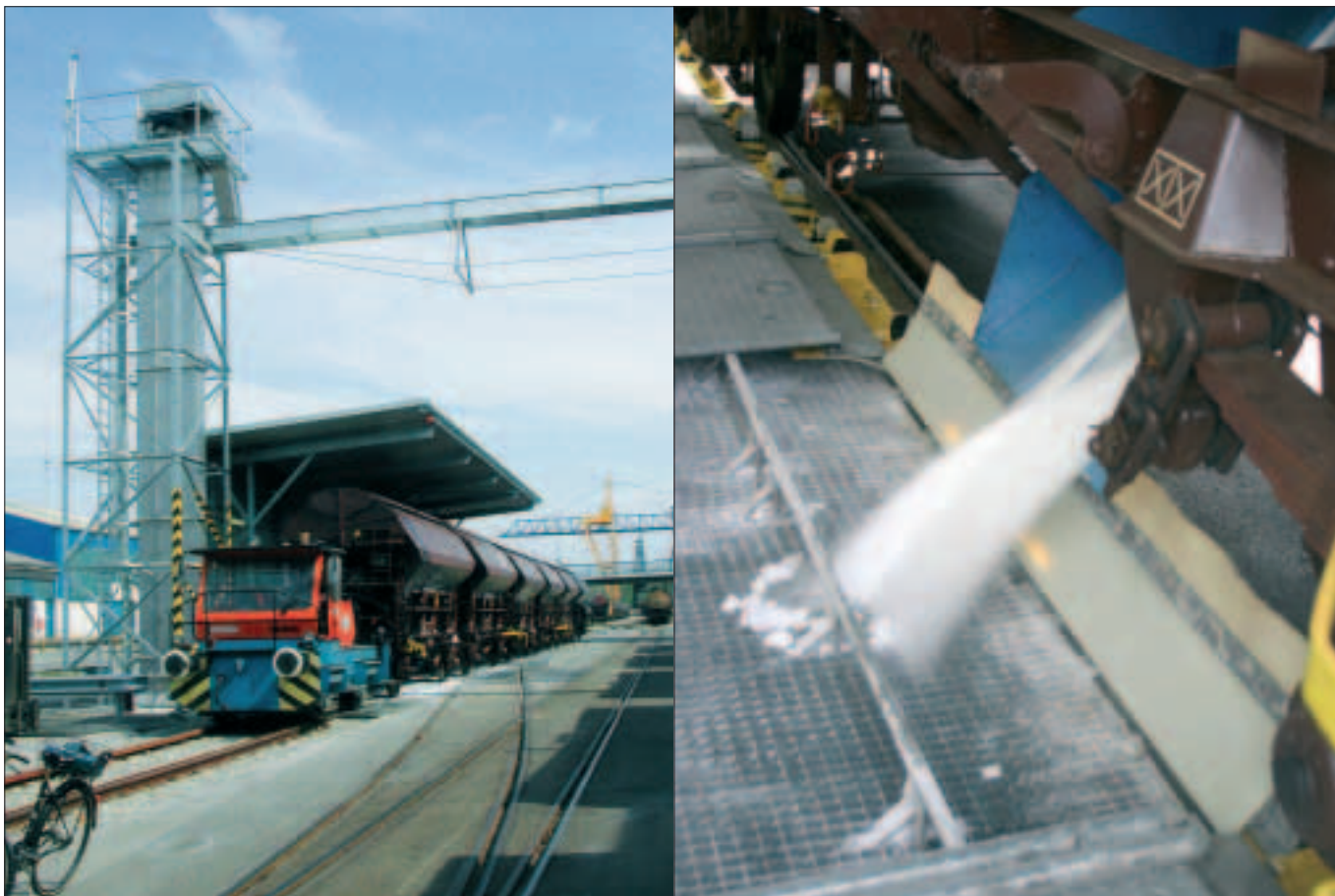
Neue Harnstoffentladung: Eine 20 m lange überdachte Schüttgosse, eine 85 m lange Förderstrecke zum Silo bzw. zum Harnstoffreaktor und eine 200 m lange Gleiseinbindung sorgen nun für eine optimale Zulieferung für die Harzproduktion.
