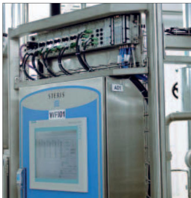
Reinstwassererzeugung bei Merckle Biotec: Prozesssicherheit mit Festo-Ventili Inseln.
