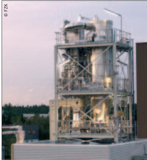
Das bioliq-Verfahren verwandelt Biomasse in vollsynthetische Diesel- oder Ottokraftstoffe, deren Qualität weit über der anderer Biokraftstoffe und selbst der Mineralölprodukte liegt. Im Bild die Schnellpyrolyse-Stufe.
