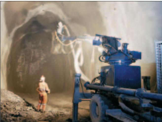
Fireshield, ein Mörtel, der im Tunnelbau eingesetzt wird, verlängert die Stabilität von Beton bei Tunnelbränden um bis zu vier Stunden – eingesetzt etwa in Teilen des Lötschberg-Basistunnels.
