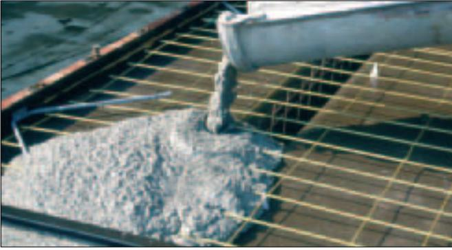
Das Verhältnis von Wasser und Zement bestimmt Konsistenz, Endfestigkeit und Dauerhaftigkeit des Betons. Glenium Sky macht das Gemisch fließfähiger und ermöglicht eine geringere Zugabe von Wasser – so erhöht sich die Festigkeit des Betons.
