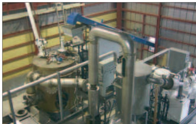
Startechs Plasma Converter System (PCS) erzeugt bei der Verarbeitung vieler Abfallprodukte ein Synthesegas, das innerhalb des kohlenstofffreien Energie-Systems als Brennstoff isoliert und in Motor-Generatoren verwendet werden kann.
