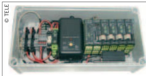
WatchDog pro ist vorkonfektioniert und damit einfach zu installieren.
