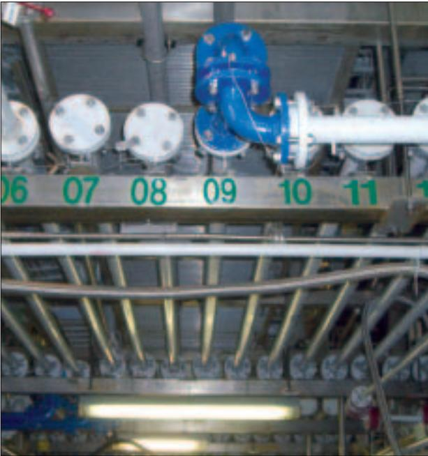
Jeder der insgesamt 19 Reaktoren im Bau 52 verfügt über eine separate Rohrleitungszufuhr.
