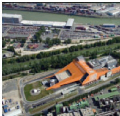
Die neue Deponieverordnung machte zusätzliche Verbrennungskapazitäten in Wien nötig. Als Nebeneffekt lassen sich mit der MVA Pfaffenau 50.000 Haushalte mit Wärme und 25.000 Haushalte mit Strom versorgen.
