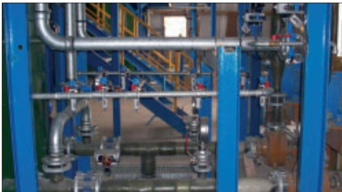
Bei jeder Abzweigung im Druckluftnetz ist eine Wartungseinheit mit Absperrventil und Filterregler eingebaut.
