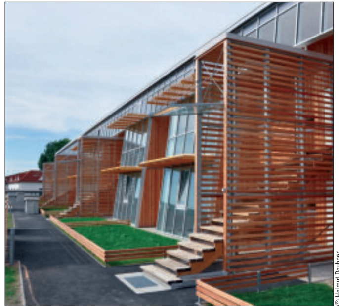
Helmut Deubner: Wohnhausanlage Sonnenhaus
