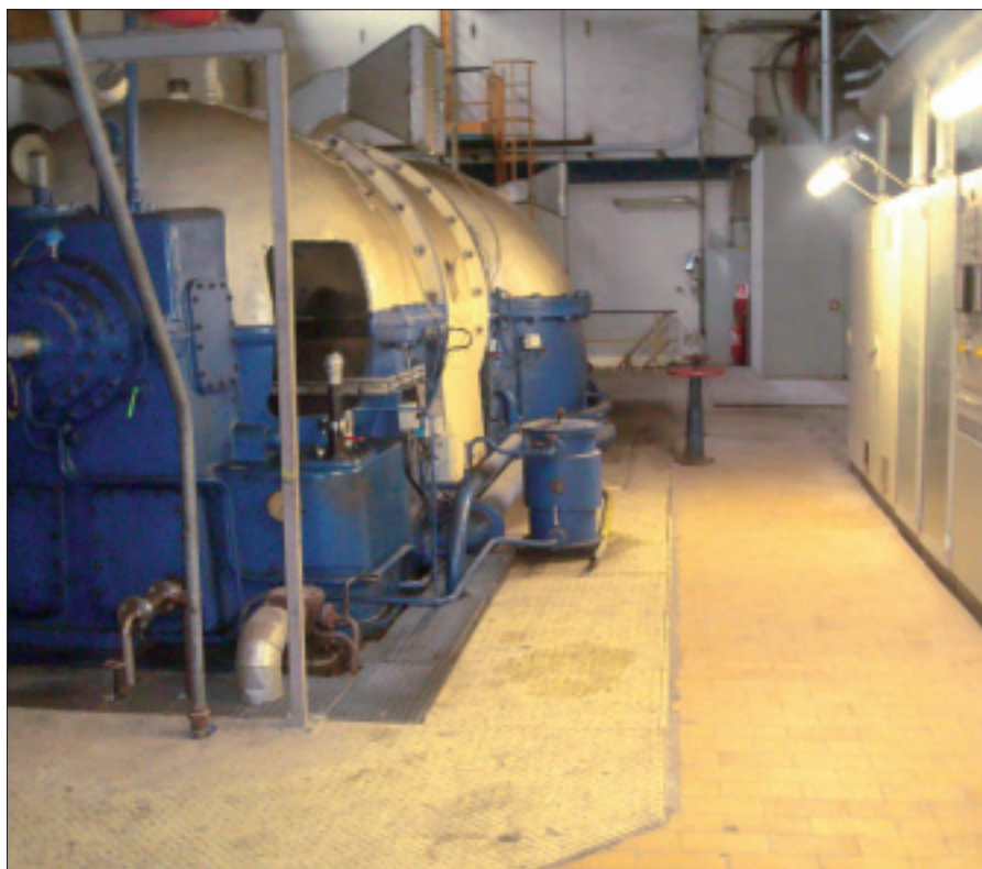
Ziel von Tereos war es, die Steuerung der Dampfkessel gleichzeitig zu modernisieren und sie in ein einziges Steuerungssystem für die gesamte Fabrik zu integrieren.
