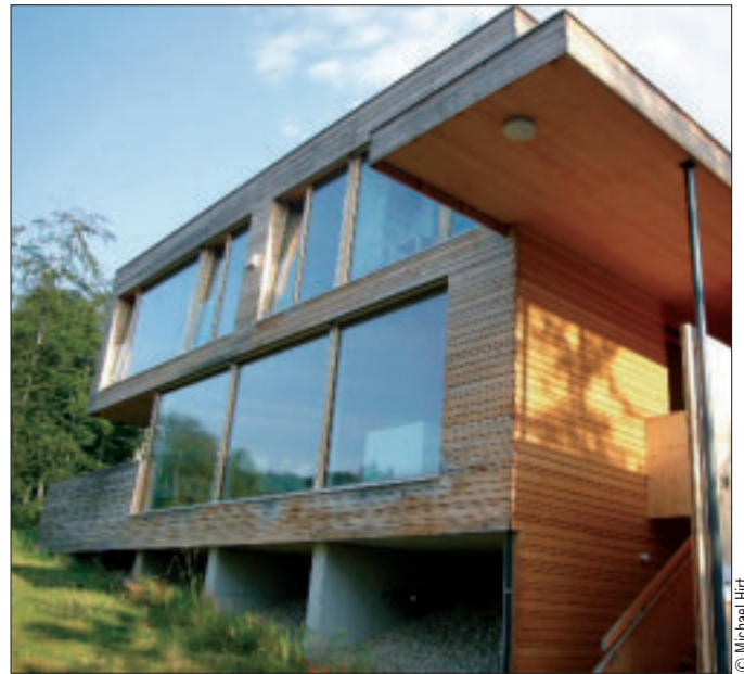
Walter Unterrainer: Passivhaus Hirt
