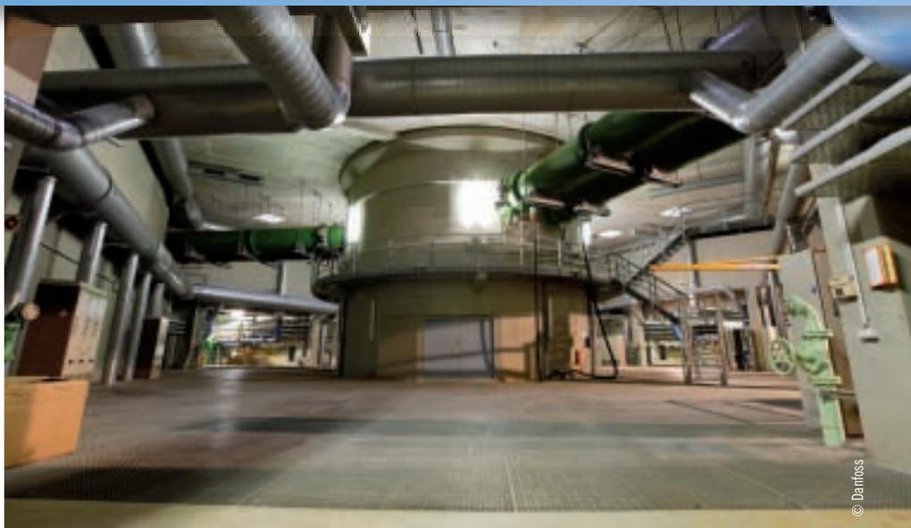
**Vier Pumpen** mit einer Leistung von 1,2 m<sup>3</sup>/s bzw. 1,8 m<sup>3</sup>/s fördern Rohwasser in den Verteilerturm.
